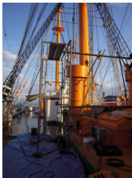
通風筒の補修工事
