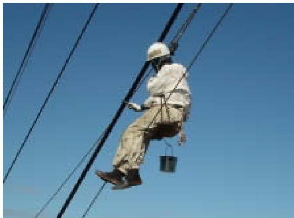
なぜ支持索にタールを塗るのでしょうか？支持索はワイヤーロープでできています。放っておくと金属なので錆びてしまい、最終的には切れてしまいます。これを防ぐために表面にタール系塗料を塗り込めて塗膜を作るのです。
