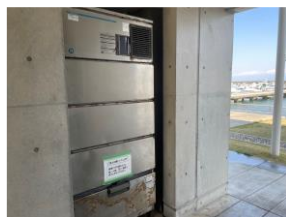
製氷機の設置
