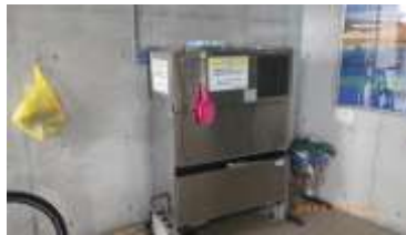
製氷機の設置
